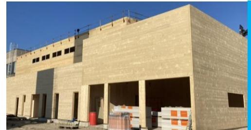
Projet « Nouveau Traitement Thermique » à Amiens
