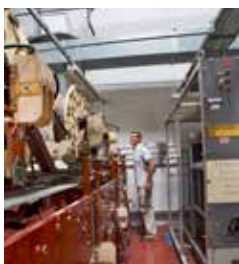
Laboratoire grande puissance
