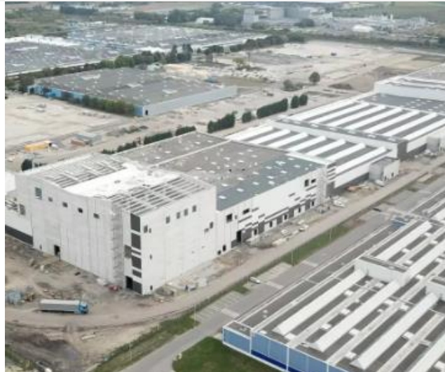
Site de la future Gigafactory de Douvrain (France)
