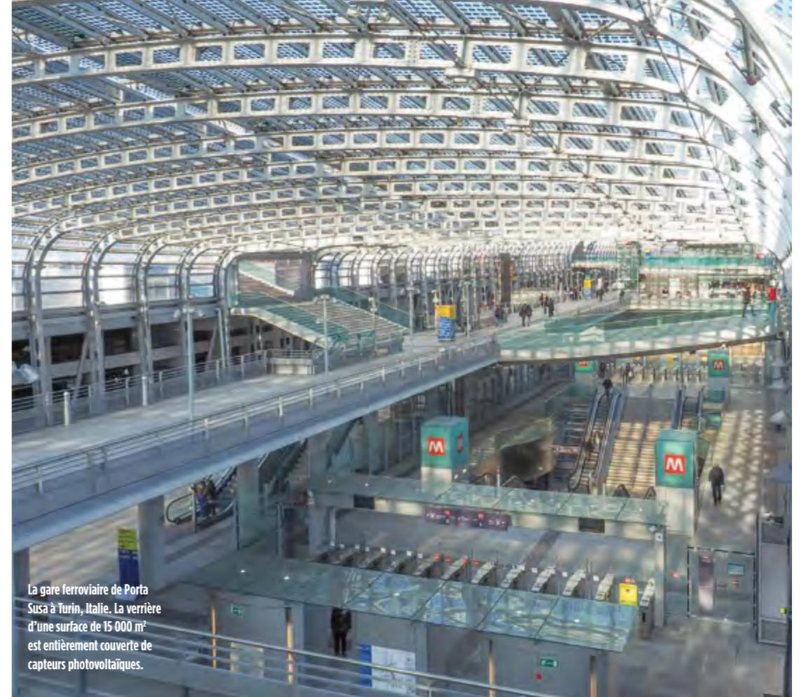
La gare ferroviaire de Porta Susa à Turin, Italie. La verrière d'une surface de 15 000 m<sup>2</sup> est entièrement couverte de capteurs photovoltaïques.
